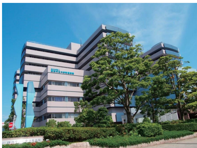
横浜市立大学附属病院 (横浜市金沢区)
